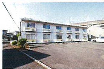
イーリスI 外観
